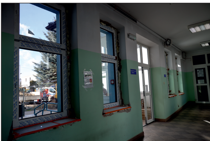
Remont ośrodka zdrowia przybiera na sile. Fot. Łukasz Rysiak
