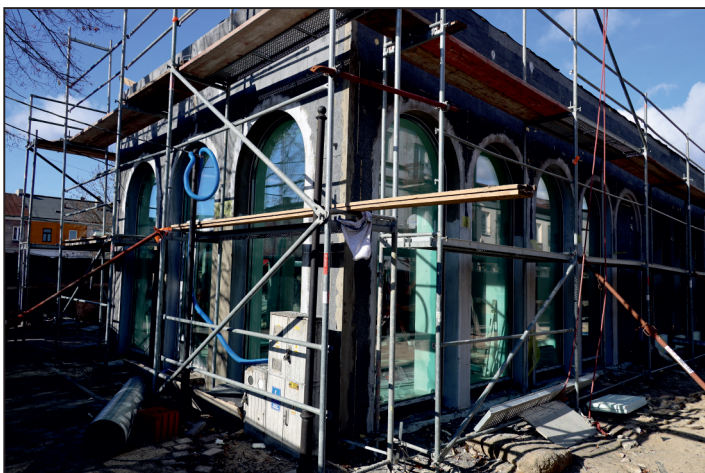
Wielkoformatowe przeszklenia pojawiły się już w budynku wystawienniczym. Fot. Łukasz Rysiak
