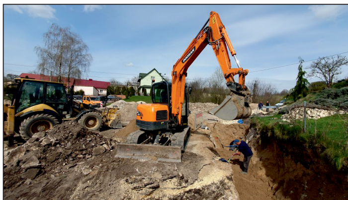
Prace przy przebudowie drogi gminnej w miejscowości Lubania. Fot. Katarzyna Więckowska
