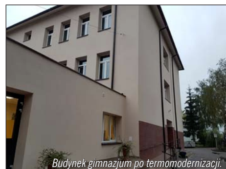
Wyremontowana sala gimnastyczna gimnazjum w Chmielniku.
