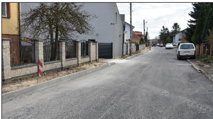
Remont ulicy Cichej w Chmielniku
