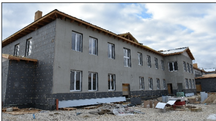
Trwa budowa szkoły podstawowej w Piotrkowicach
