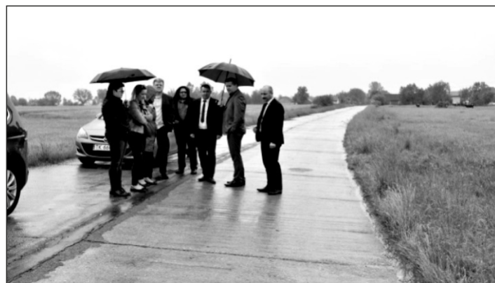
Droga z płyt betonowych w kierunku Kotlic
