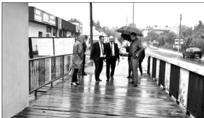
Wymagający remontu most na ul. Dygasińskiego w Chmielniku
