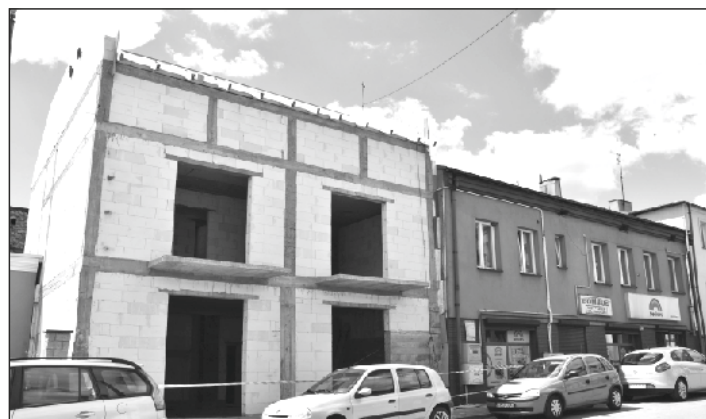
Rozbudowa sklepu przy ul. Szydłowskiej Fot. Edyta Gruszczyńska
