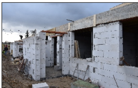
Trwają prace przy rozbudowie wielorodzinnego budynku socjalnego przy ulicy Mielczarskiego. Fot. Edyta Gruszczyńska
