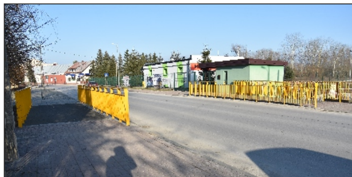
Wyremontowane kładki na ul. Dygasińskiego Fot. Edyta Gruszczńska
