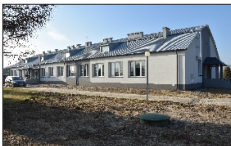
Zakończyła się termomodernizacja budynku Środowiskowego Domu Samopomocy oraz świetlicy wiejskiej w Zreczu Dużym. Fot. Edyta Gruszczyńska
