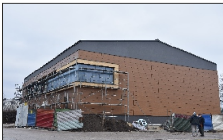
Budynek nowej sali gimnastycznej przy chmielnickiej podstawówce już zyskał elewację. Fot. Edyta Gruszczyńska
