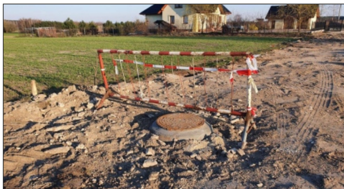
Rozbudowa sieci wodno-kanalizacyjnej w Śladkowie Małym. Fot. Katarzyna Więckowska
