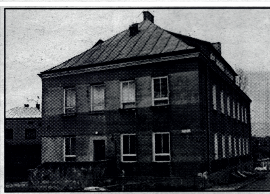
W tym budynku mieści się w chwili obecnej Przychodnia Rejonowa w Chmielniku. Ten ponad 30-letni obiekt wymaga natychmiastowego remontu. Nie spełnia on też oczekiwań mieszkańców i pracujących tam lekarzy i pielęgniarek ze względu na ciasnotę pomieszczeń.
