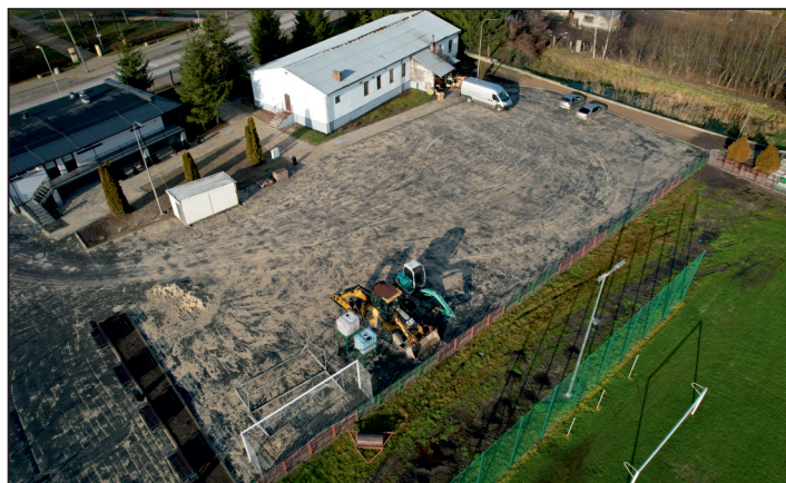
Trwa remont obiektu MLKS Zenit Chmielnik. Fot. Łukasz Rysiak
