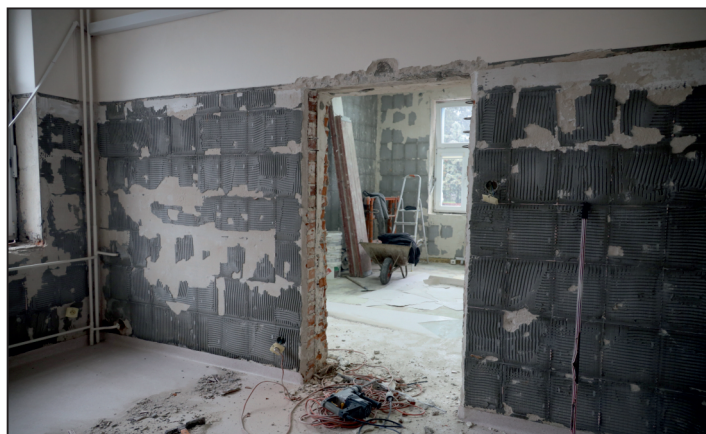
W ośrodku zdrowia w Chmielniku ruszyły prace termomodernizacyjne. Fot. Łukasz Rysiak
