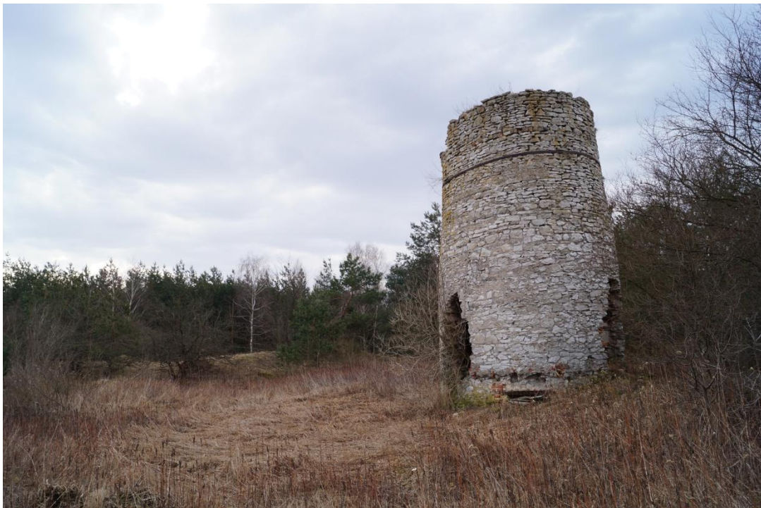
Zachowany w dobrym stanie piec wapiennicy. 2018 r.
