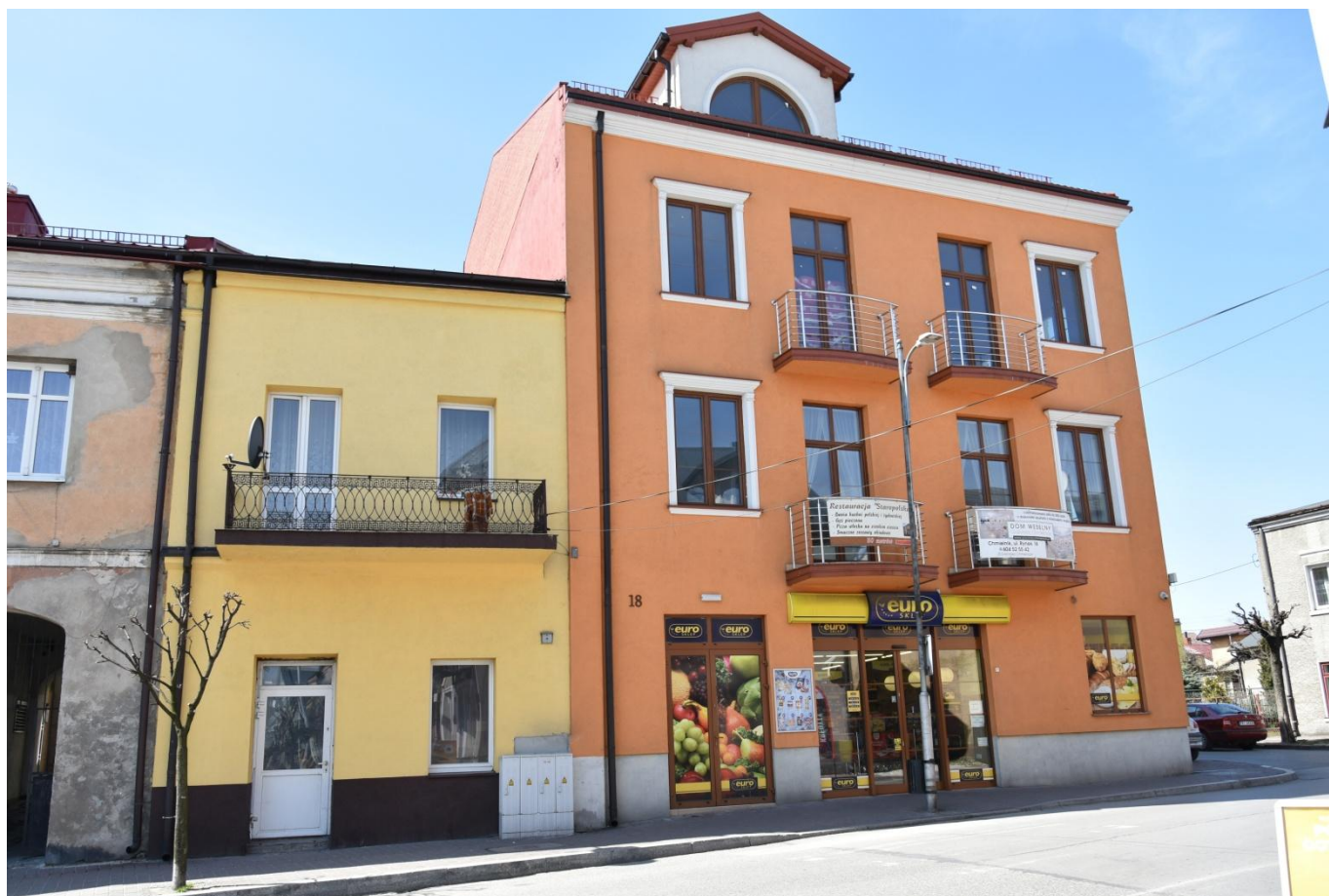
Kamienica nr ■. Elewacja zachodnia. 2019 r.
