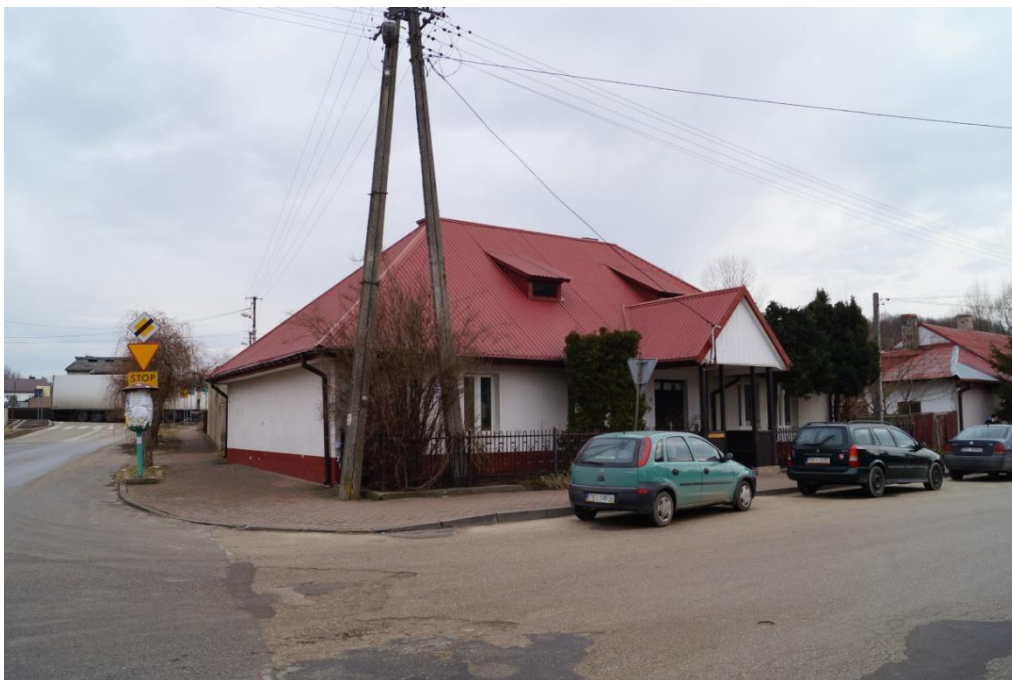
Dom murowany. Przebudowany na zewnątrz i wewnątrz. Stan 2018 r.
