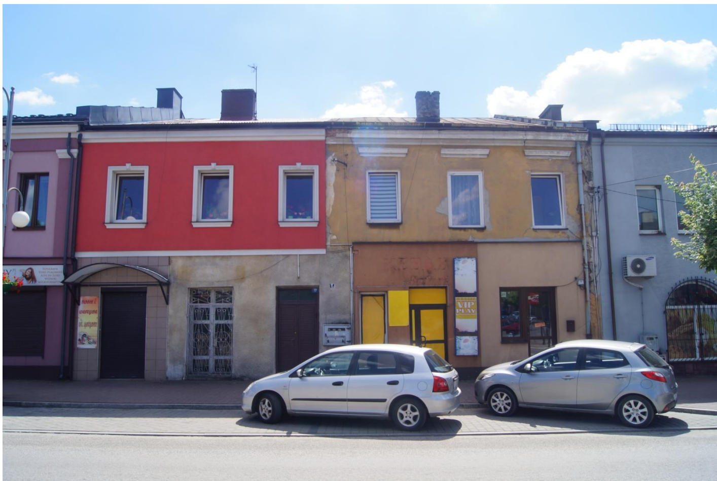
Kamienica nr [REDAKTOWANE]. Elewacja północna. 2018 r.
