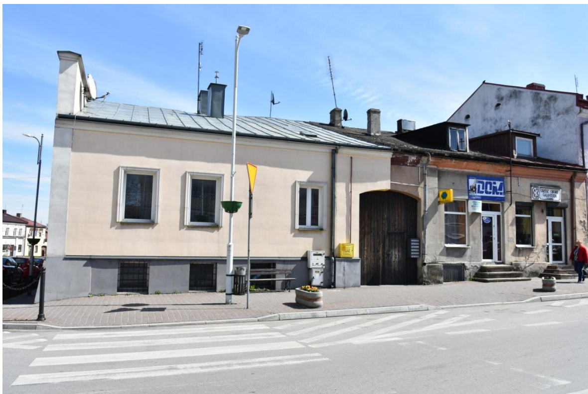
Dom, elewacja zachodnia. 2019 r.
