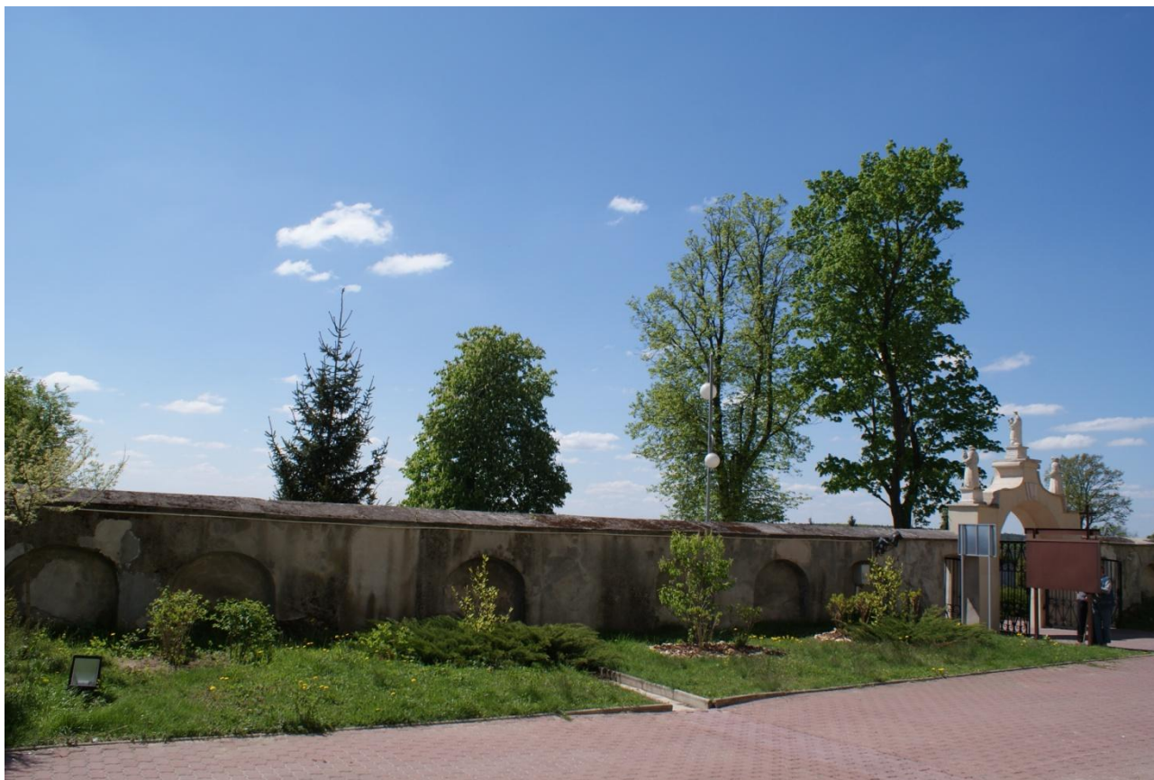
Mury ogrodzenia od strony południowej. 2018 r.
