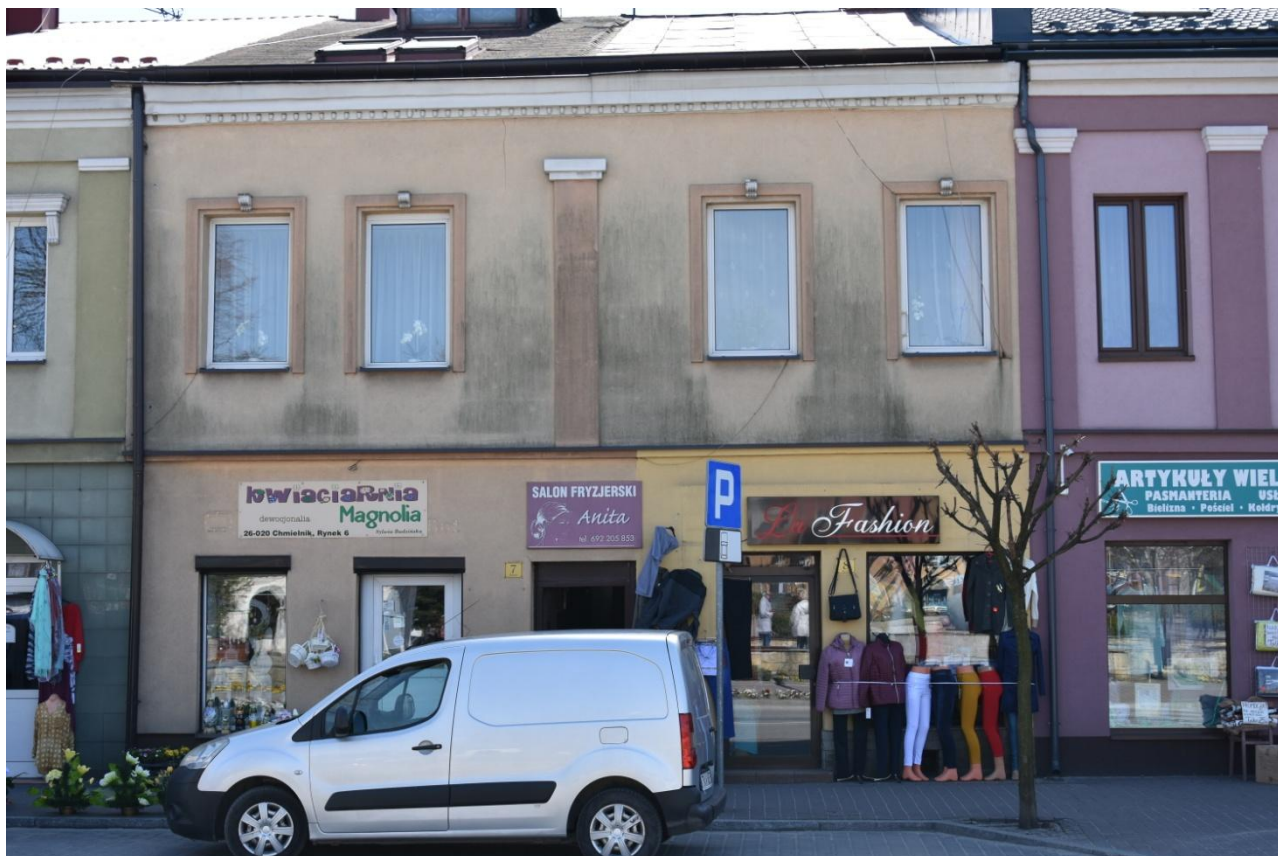
Kamienica nr [REDACTED]. Elewacja północna. 2019 r.
