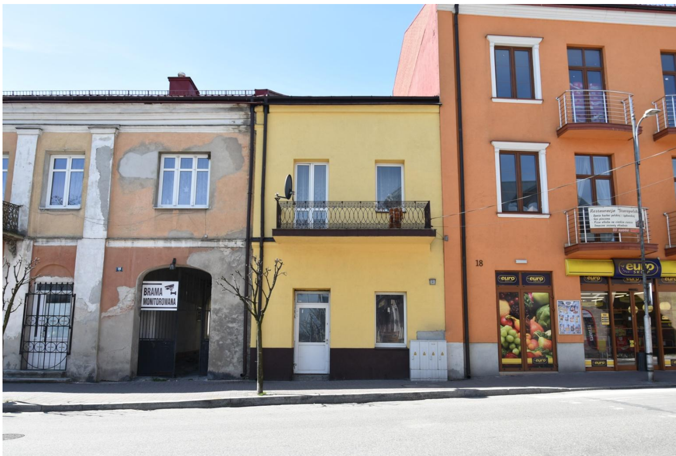
Kamienica nr ■. Elewacja zachodnia. 2019 r.
