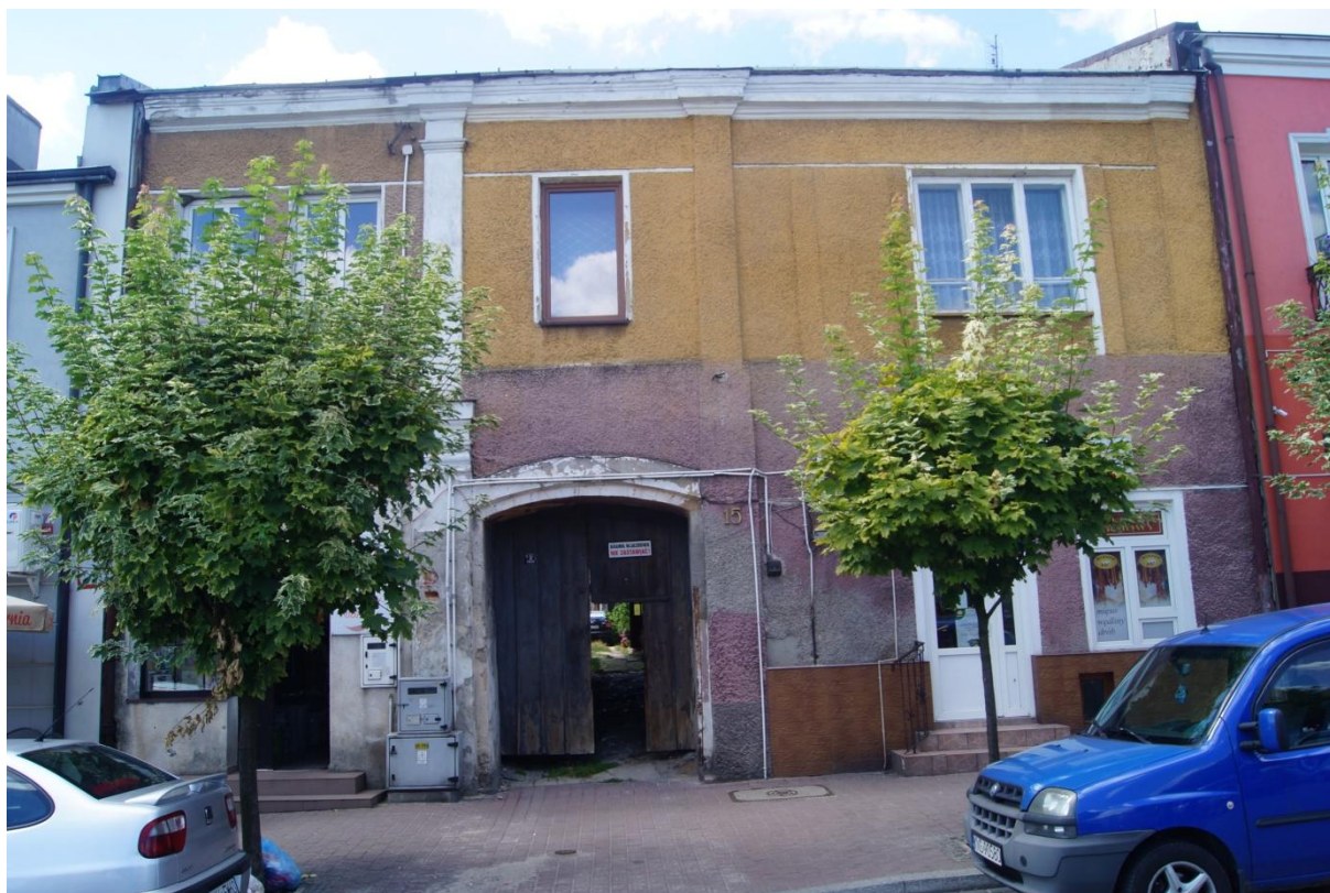
Kamienica ■■■ Elewacja zachodnia. 2018 r.
