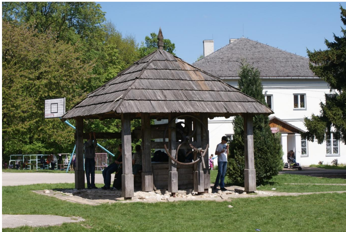
Studnia na dziedzińcu w zespole pałacowym. Zdjęcie od południa. 2018 r.
